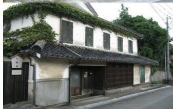
⑦小倉屋(こくらや) 小倉屋と号し、江戸後期以来この地に居住していた地主で、質屋でした。主屋2階に明治13年(1880)の建築と記された棟札が残っています。明治時代前半の姿を良く留める町屋建築です。
